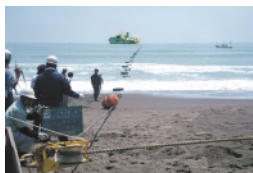
海底ケーブルの陸揚げ作業 沖合の敷設船は すばる
