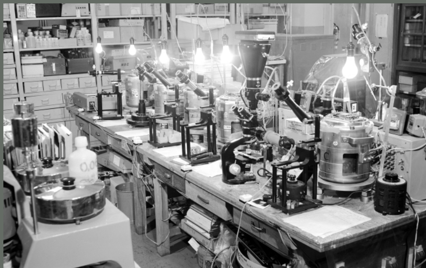
ワイヤスプリング継電器の試験
